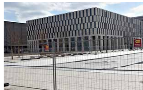
Tapssluk: Hotell Steigenberger ved inngangen til terminalbygningen holder ventilasjonsanlegget i gang, i påvente av at flyplassen en gang skal åpne. FOTO: PER-IVAR NIKOLAISEN
